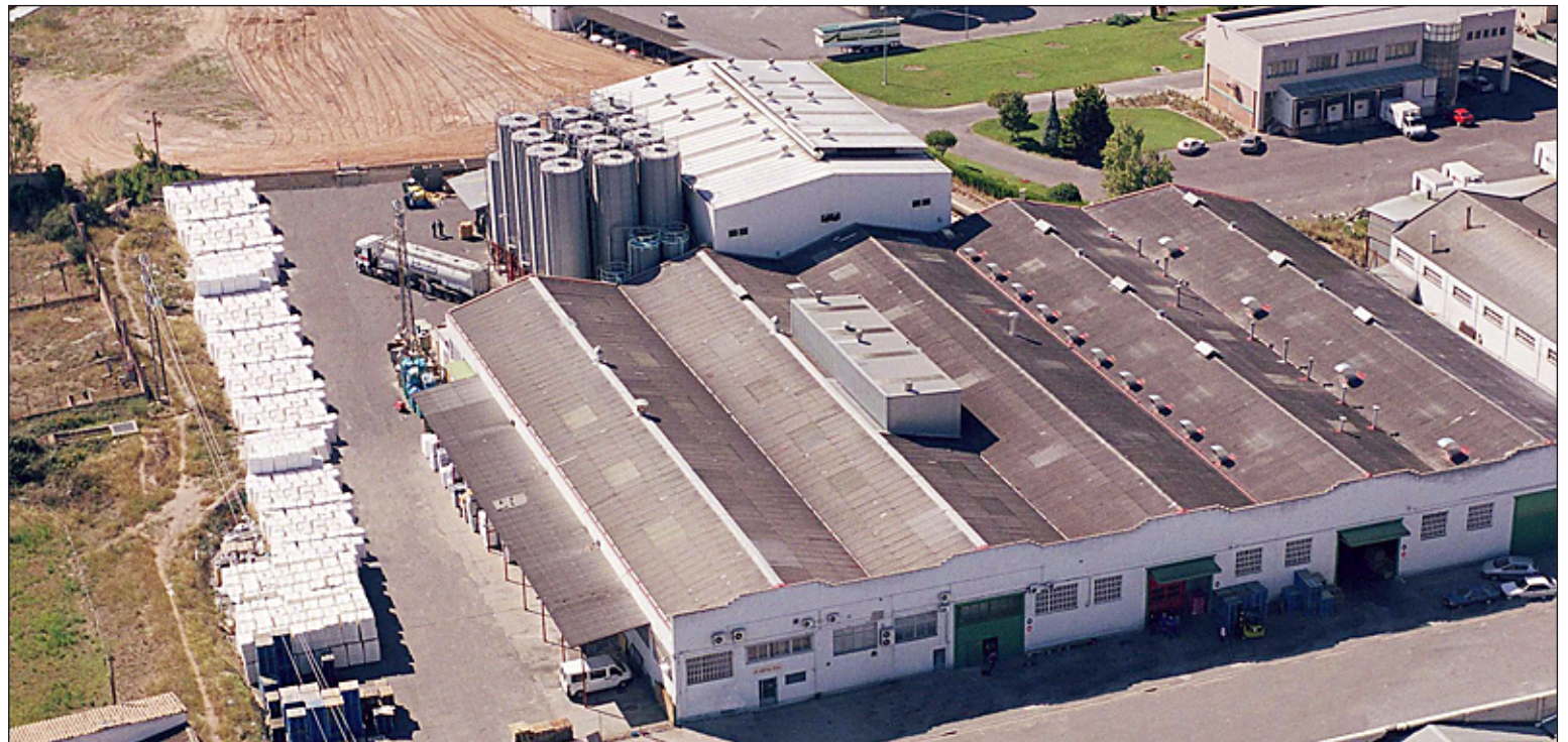
Instalaciones de Sphere España en Zaragoza
